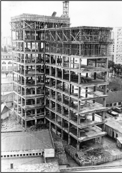
Figura 1 – Prédio da Faculdade de Educação em construção
