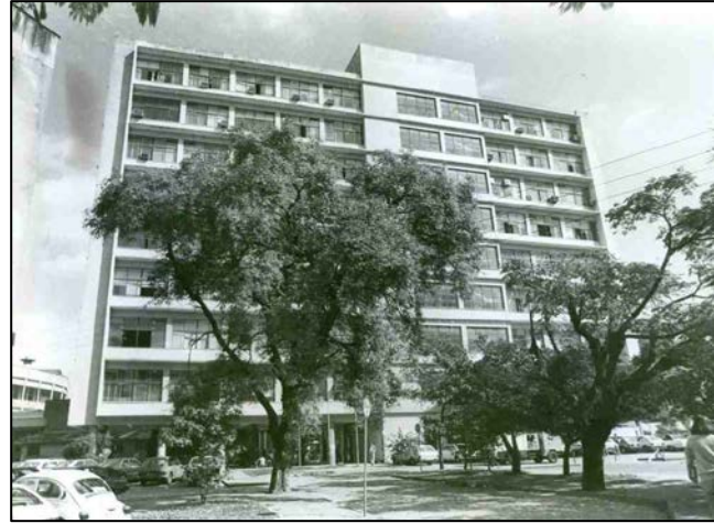
Figura 2 – Prédio da Faculdade de Educação, pronto.
