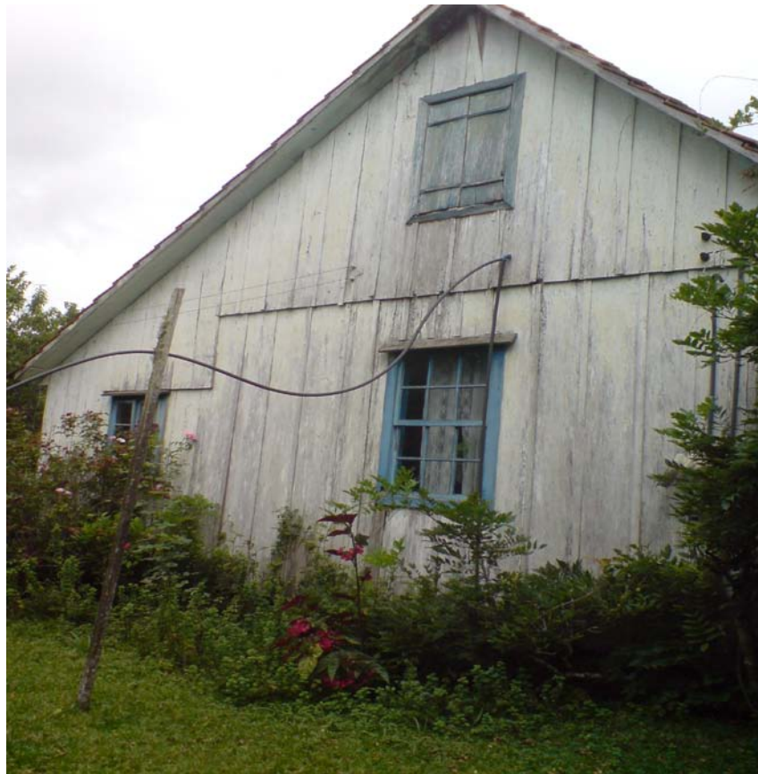
Figura 1: Casa de Likéria Oratz, construída em 1975. Papanduva Fonte: Fotografia do autor, mar. 2009.
