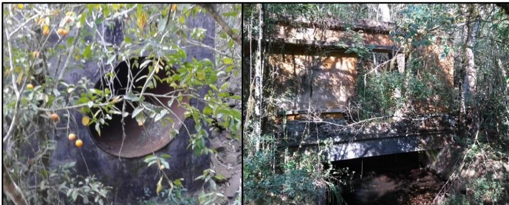
Figura 2 - Ruínas da Antiga Usina Salto São João no Parque Estadual Lago Azul, município de Campo Mourão
