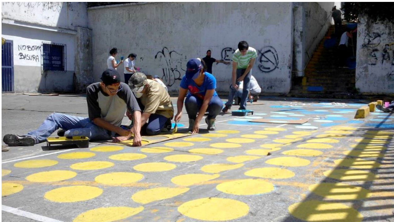
Figura 05: Elaboração da intervenção. Fonte: CCS Vinculada (2018).
