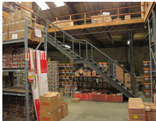
Figura 4 – Escada que dá acesso ao mezanino Fonte: Autor (2013)
