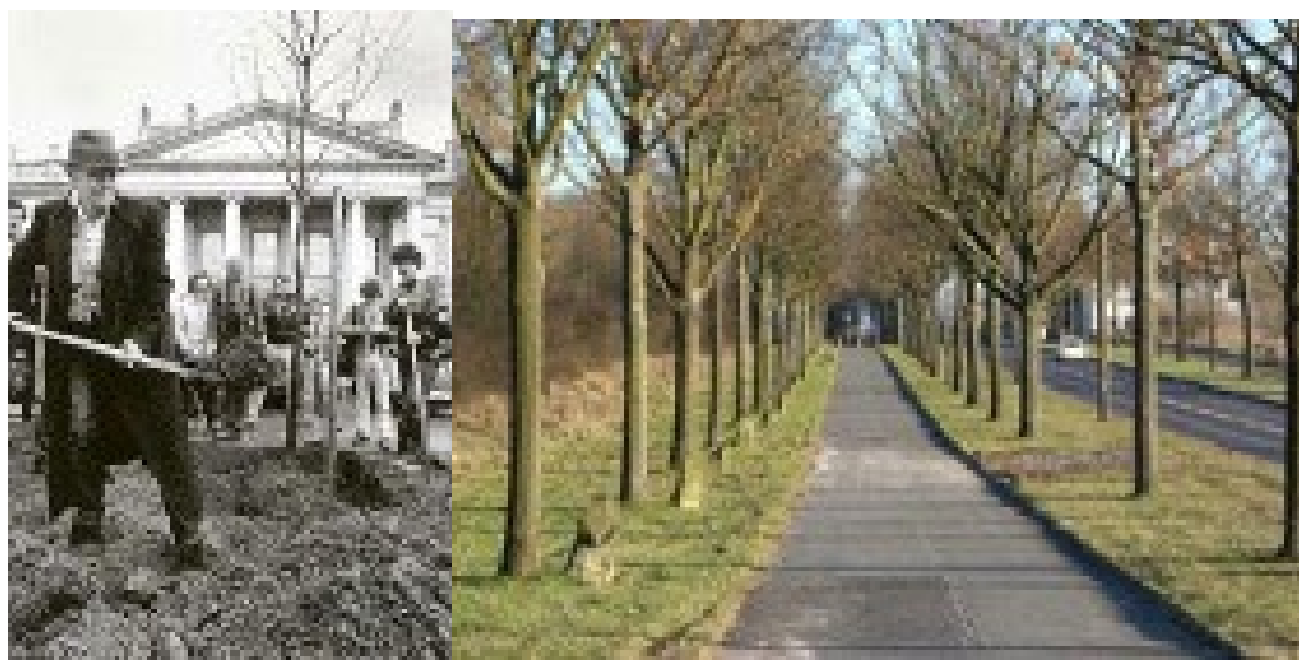
Figura 5 – Sequência da obra 7.000 Carvalhos
